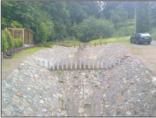
Abb. 6: Neuerrichtete Rückhalteanlage für Treibgut und Geschiebe, Blick stromauf, 29.06.2017
