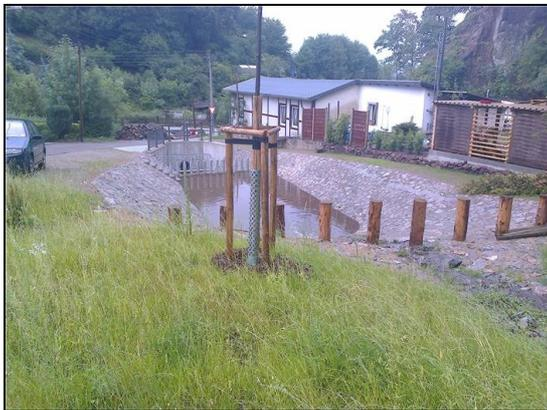
Abb. 5: Neuerrichtete Rückhalteinlage für Treibgut und Geschiebe, Blick stromab, 29.06.2017
