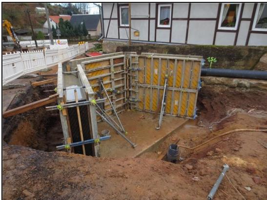
Abb. 4: Neubau Rückhalteinlage für Treibgut und Geschiebe, 02.12.2016
